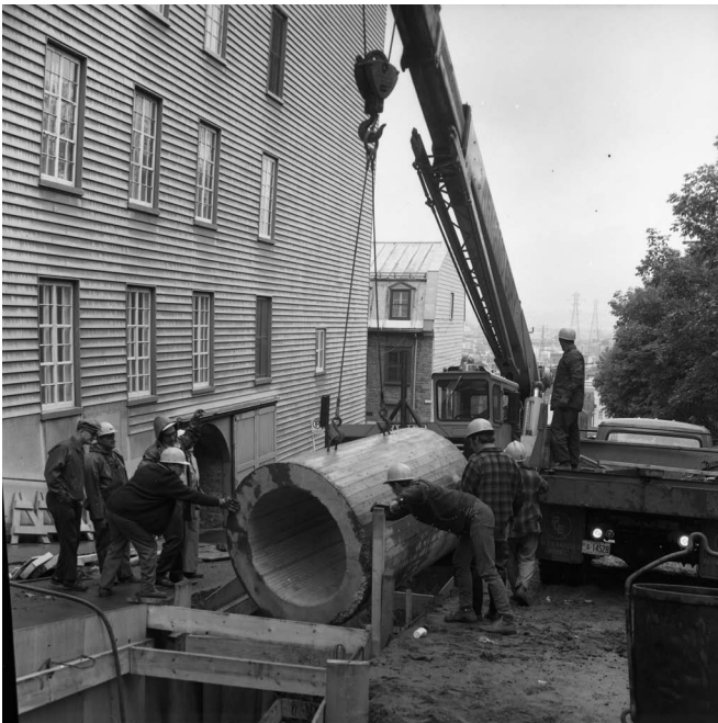
Travaux municipaux dans une rue de Québec, 1969 (Archives Ville de Québec)
